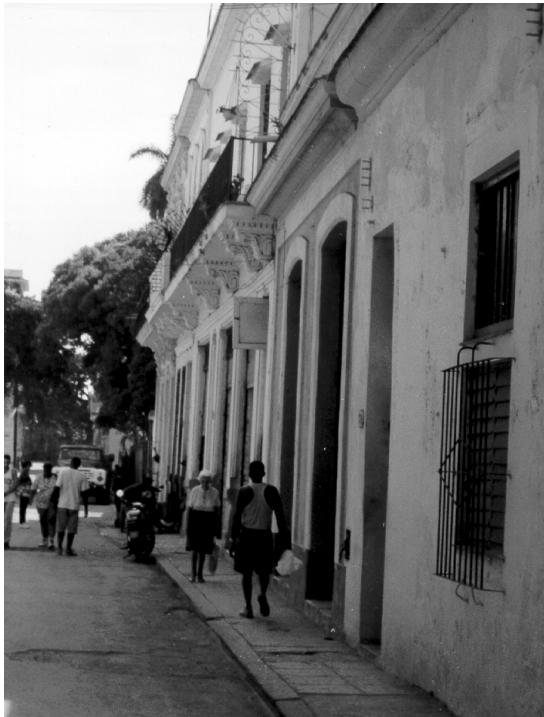
Tramo de la calle San Isidro rehabilitada
